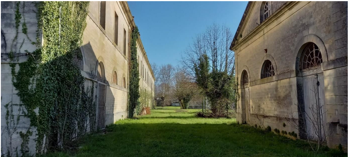
Photo 6 : vue entre bâtiment principal et ailes
