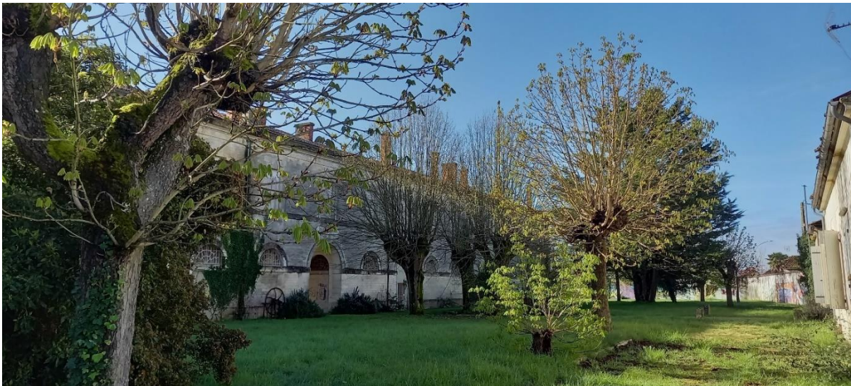
Photo 3 : le parc face au bâtiment principal côté avenue Général Leclerc
