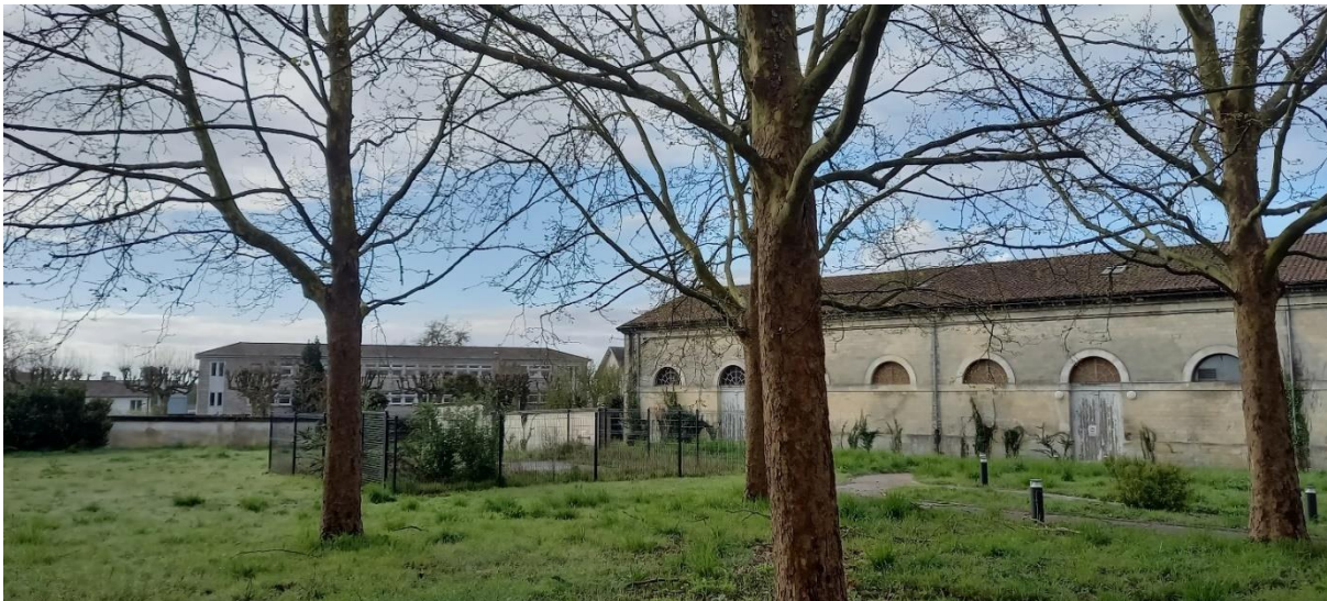
Photo 1 : l'enceinte grillagée du forage des Capucins face au bâtiment expérimental
