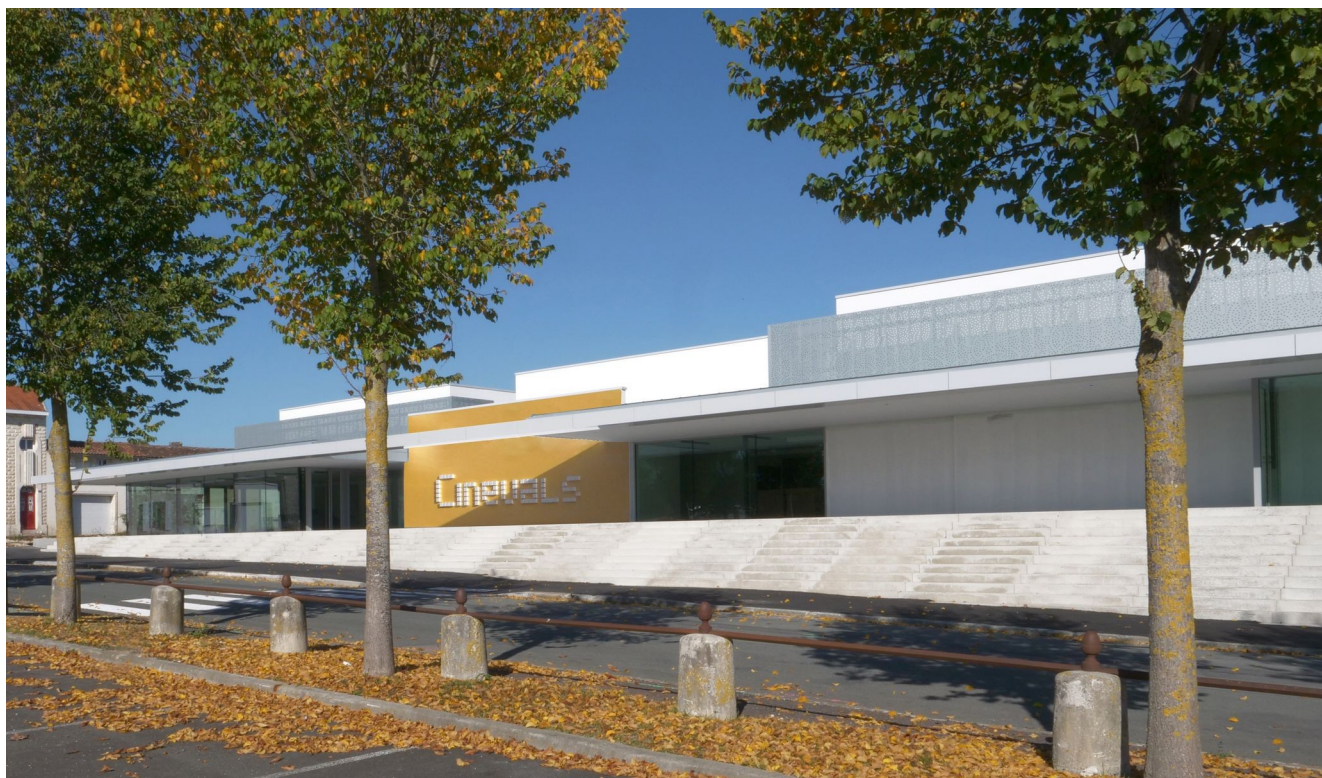
Vue du nouveau cinéma à Saint-Jean-d'Angély
